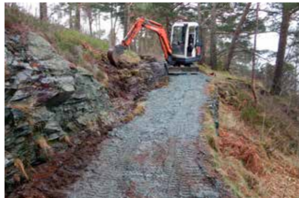
Grønskjeret: Skjøtsel og utbedringer av turveien.
