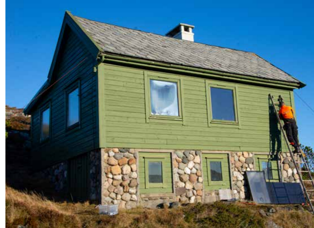
OPPGRADERING OG VEDLIKEHALD: Montering av solventilator og solcelleanlegg.
